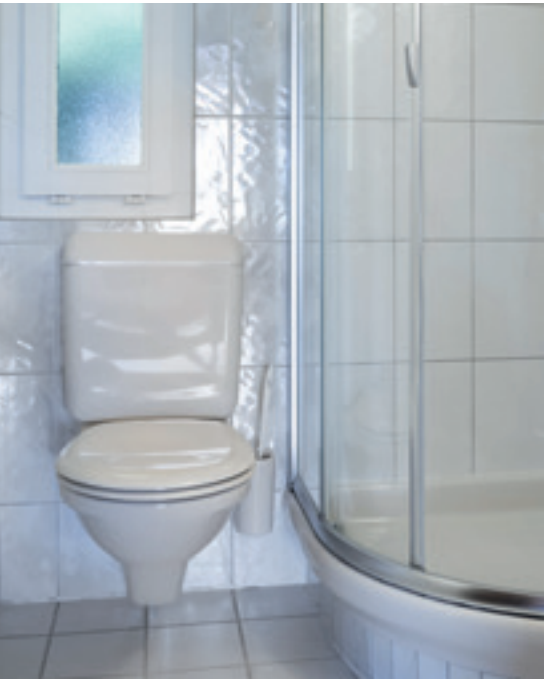
ÎNAINTE Situatie de instalare cu rezervor aparent
